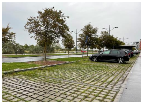
Bilden visar exempel på en parkeringsplats utfört med gräsarmering
