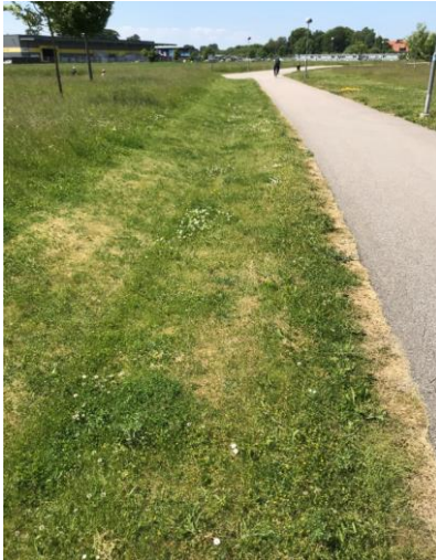
Bilden visar avvattning till sidoskåldike.
